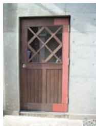
写真2：修理されたドア
