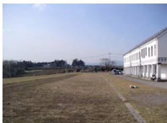
写真3：100m 走のスペース となった大学建設予定地
