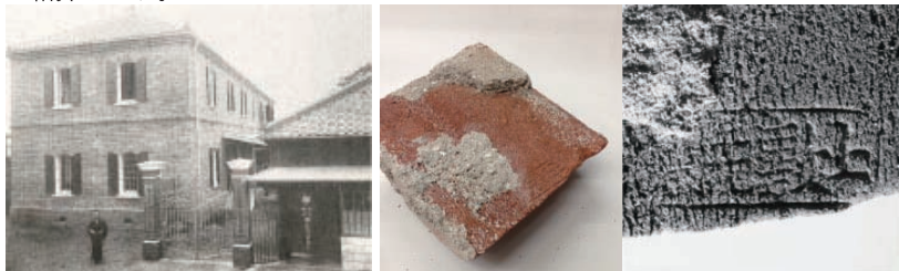
旧本庄商業銀行煉瓦倉庫 建設当初の写真資料 建物に用いられている煉瓦の一部に製造元が記されている
