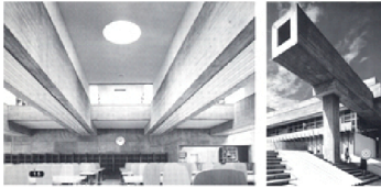
図4)大分県立図書館:内観と外観 出典=『建物が残った』
