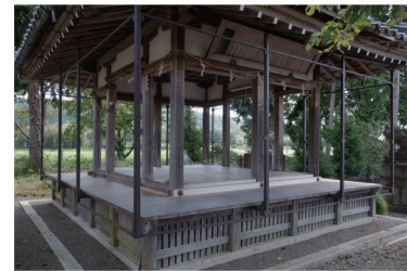
(図15) 雪囲いの鉄骨枠組み—白山神社(保延寺)
