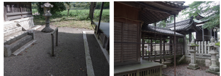
(図2) 掘立の橋脚_白山神社(保延寺)_左 (図3) 増築された通路_八幡神社(柏原)_右
