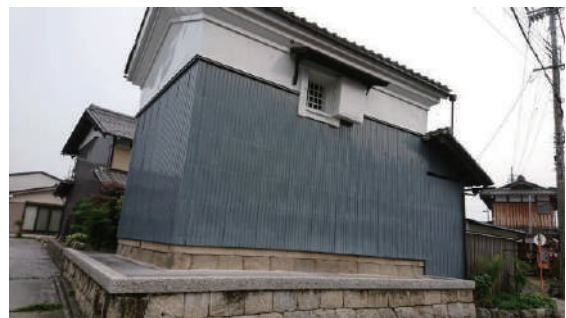
図19 建物のかさ上げ
