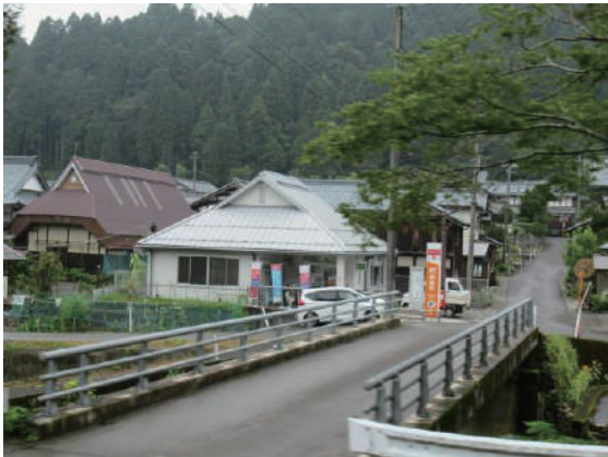
図4 元茅葺屋根の住宅
