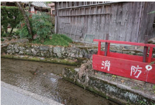
図 17. 集落内の消防用具の設置（細井撮影）
