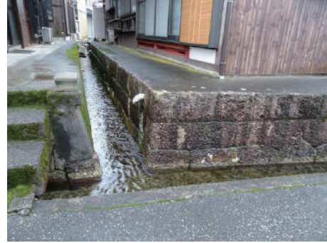
図 14. 集落内の水路による排水（伊東撮影）
