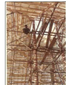
図11 施工時の乞食城の「塔」の様子
