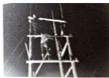
図7 「塔」の施工の様子
