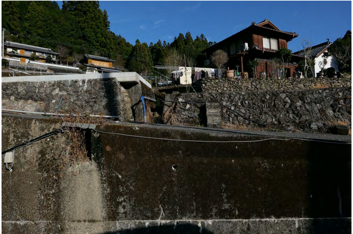
図 4 花瀬の集落内の水道管の様子（写真中央部）
