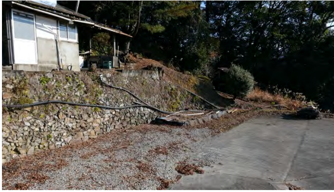
図 6 水道管が斜面を降りていく様子
