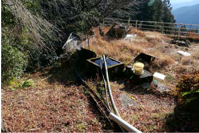
図 9 コンクリート製の貯水槽
