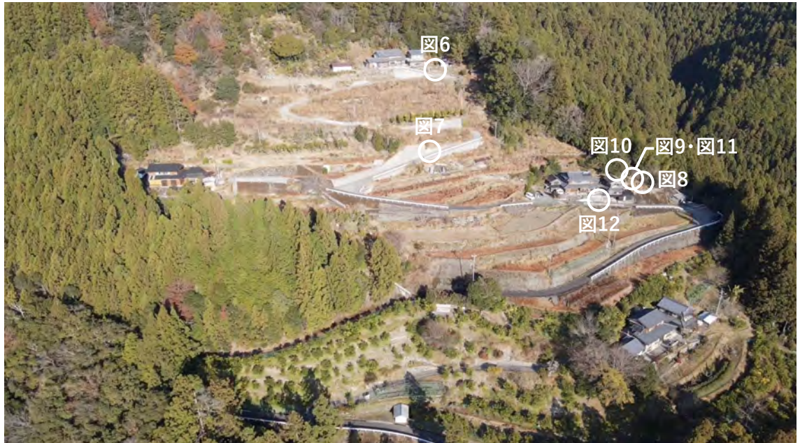
図5 音谷田ノ久保における写真の撮影地点
