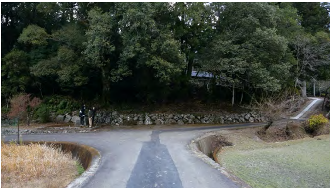
図 15 右手の方の神社へ上っていく水道管の埋設跡
