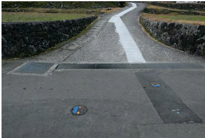
図 14 仕切弁の蓋と住居の方へ上っていく水道管の埋設跡
