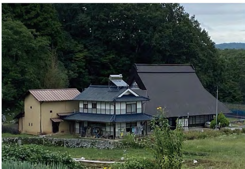
図 4：正面入り口横に 風呂を配す民家
