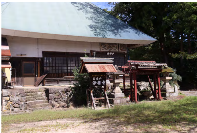
図 13 集落の中の寺で利用されている石材の状況。ほとんどが大山由来のデーサイトである。
