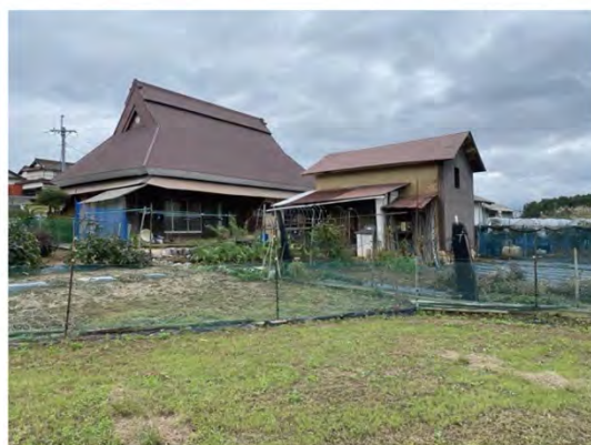
図 5-2：主屋前面に土蔵を置く民家
