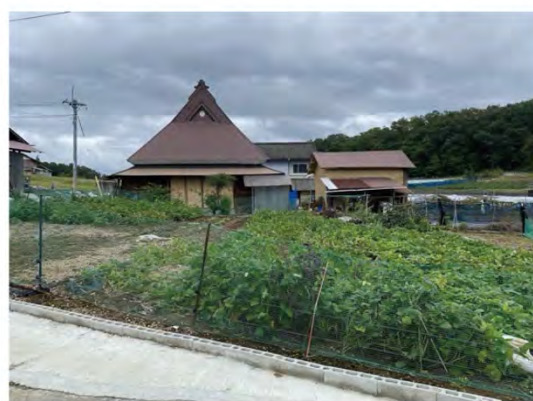
図 5-3：主屋前面に土蔵を置く民家
