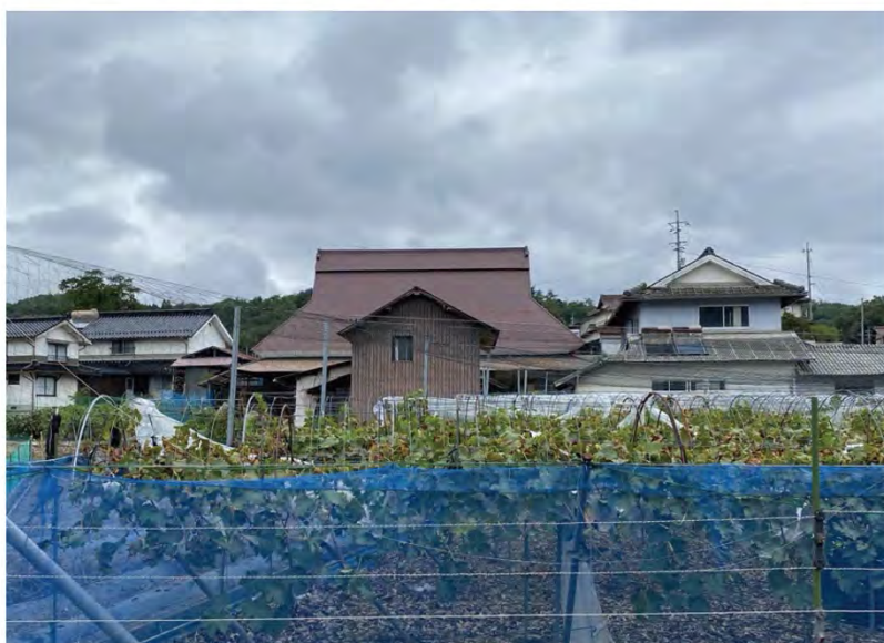
図 5-1：主屋前面に土蔵を置く民家
