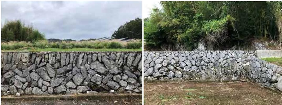
図 2-10 (左) 図 2-11 (右) 石灰岩による石垣
