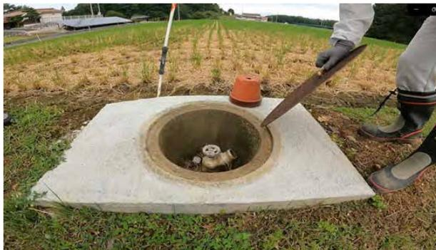
図 2-3 灌漑用水を田に引き込む取水口
