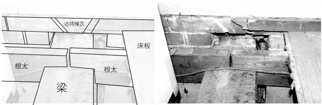
図 4.8 煉瓦壁への二階床の梁の挿入される様子
