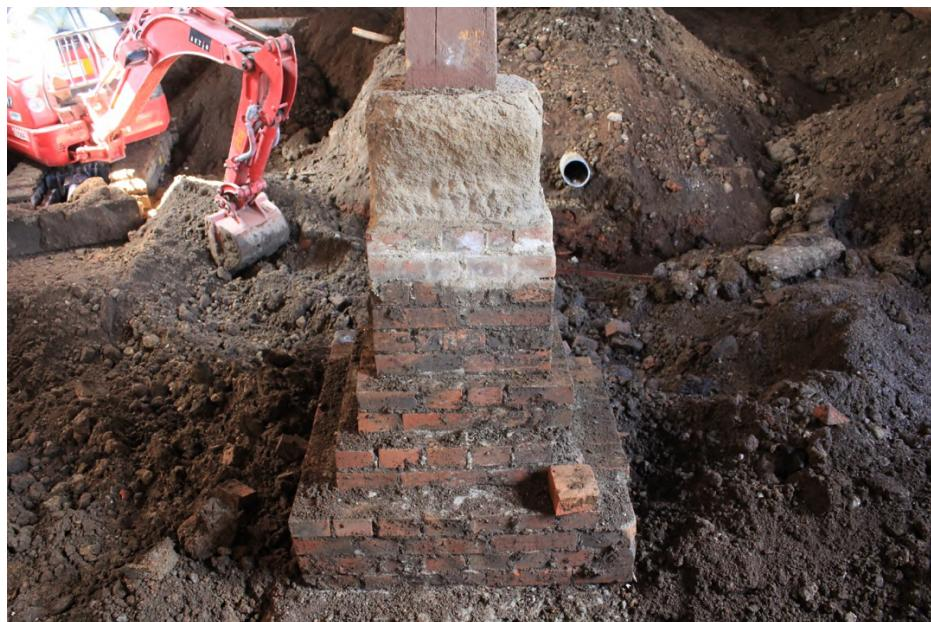
図 3.3 一階支柱・礎石の下部に積まれた根積み
