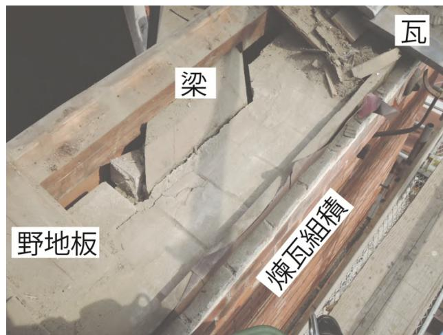
図 4.11 煉瓦組積上部におけるトラスの乗せ方
