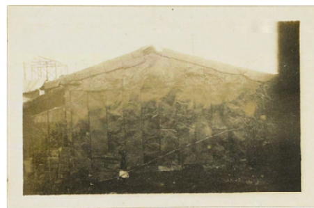
図3 建築物の壁面から屋根までをトタン板で包んでいるように見える
