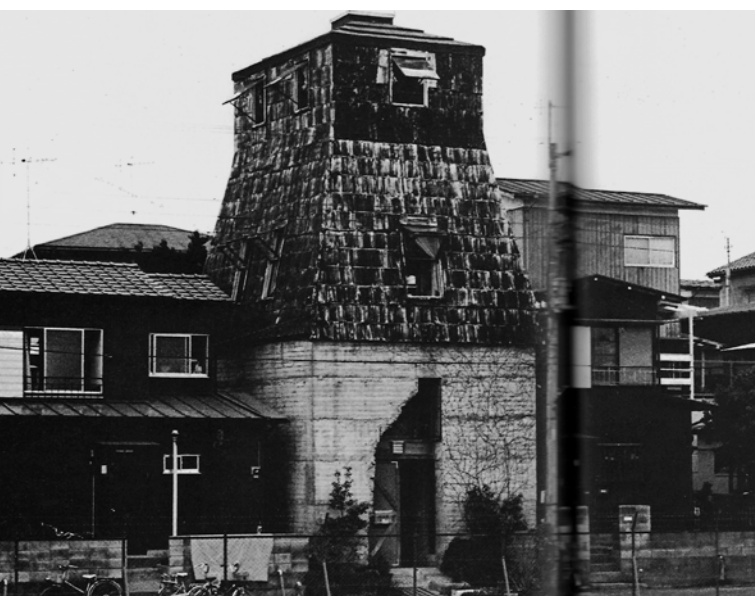
山根锐《乌鸦城》（カラス城） [1] 1970-1972，使用了废弃的铁桶作为混凝土模板
