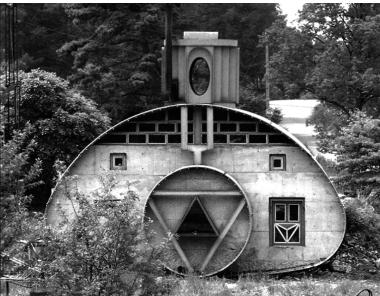
石山修武《开拓者之家》（開拓者の家） [5] 1974-1986，使用波纹钢板
