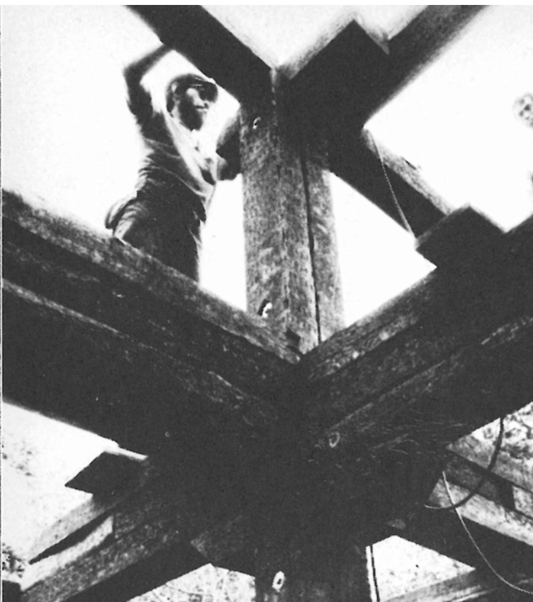
生斗学舍的建设现场 [2]
