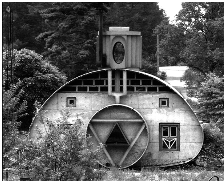
開拓者の家 / 石山修武 / 1974-1986 / コルゲーションパイプ [5]
