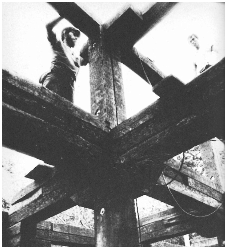
生闘学舎の建設現場 [2]
